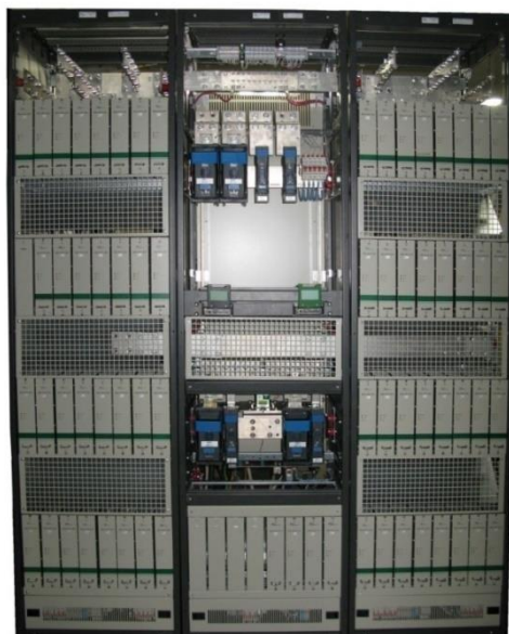
Рисунок 7.1 - ЭПУ в составе двух стоек СУЭП-3 (справа и слева) и ЩТР-3 (в центре)
