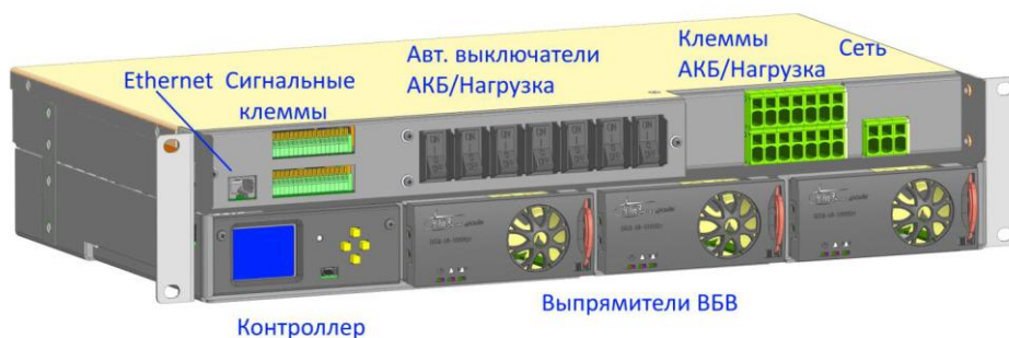
Рисунок 1.5 – Вид спереди и расположение клемм УЭПС-7К 48/66-33-1Т
