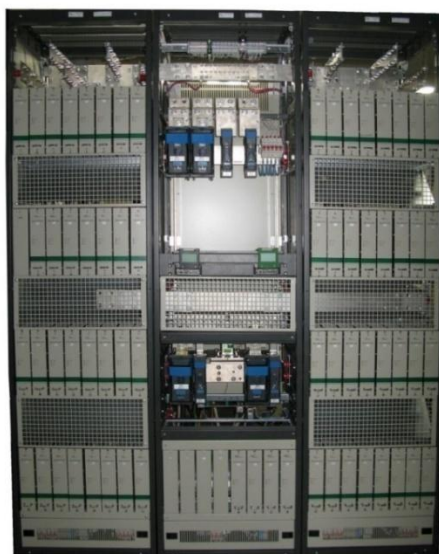
Рисунок 7.1 - ЭПУ в составе двух стоек СУЭП-3 (справа и слева) и ЩТР-3 (в центре)
